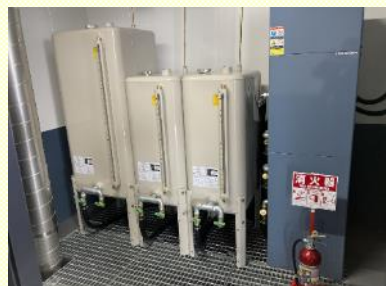
新油バルクタンク 500L・250Lの大容量のため 流出時の緊急訓練が重要
