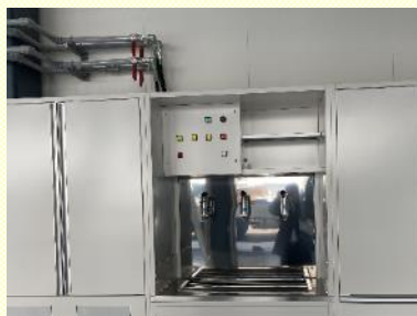
オイル圧送設備 圧力がかかる配管・バルブの 状態を点検
