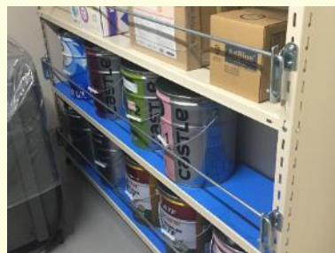
落下防止柵 地震時の落下に備えて 柵をセット
