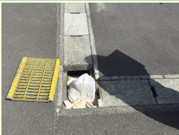
土嚢・吸着マットを側溝に詰める 先回りして水路を塞ぐ
