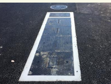
油水分離槽 毎週点検により汚水状態の管理 定期水質調査・定期洗浄の実施
