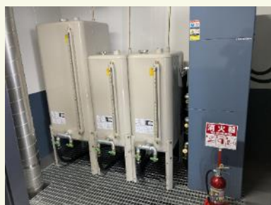
新油バルクタンク 500L・250L 流出時の緊急訓練の実施
